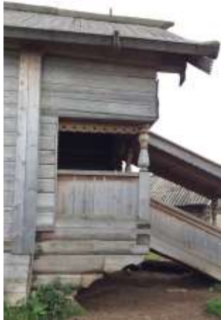
Крыльцо на выпусках
