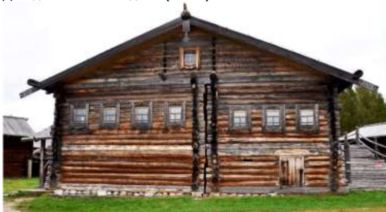
Дом двойня из холодной (слева) и теплой избы
