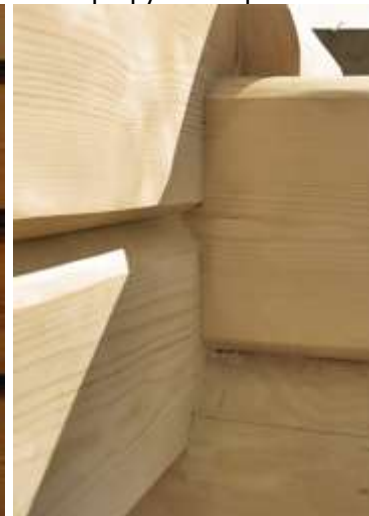
Угол при рубке в крюк
