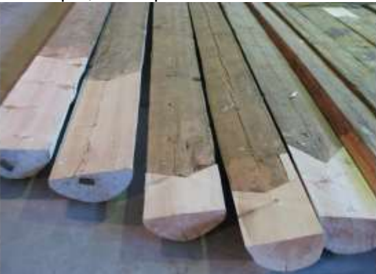
Реставрация исторических плах
