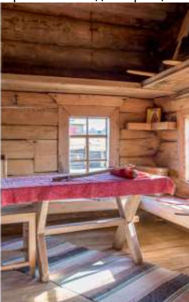
Протеска стен до "воронцов"
