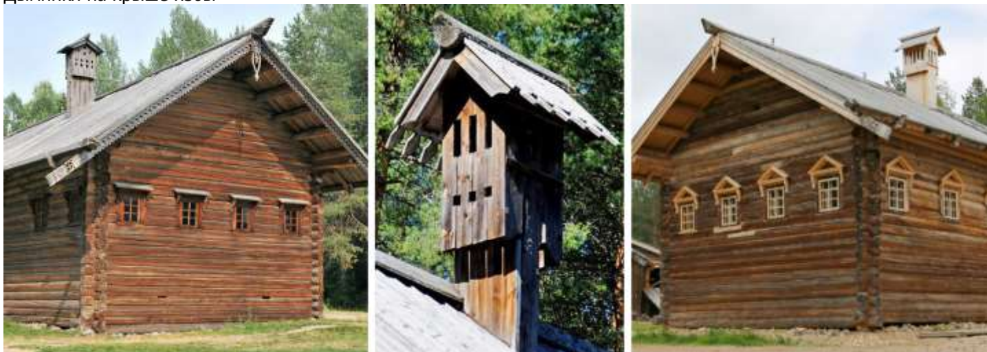
Дымники на крыше избы
