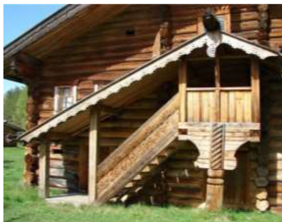
Крыльцо на одном столбе
