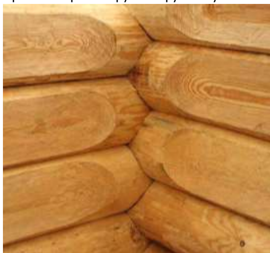
Протеска бревен сруба в круглый угол
